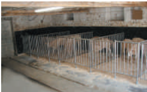
Des cases conçues avec le plus grand soin : acier inoxydable, habillage en PVC des murs
